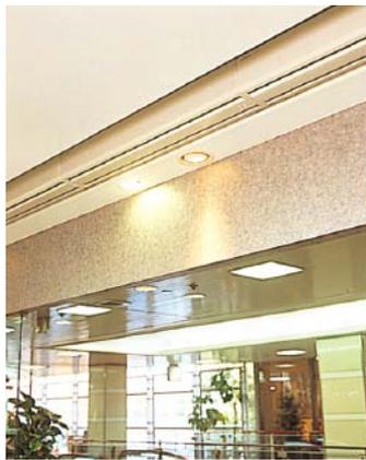
●冷房時の冷気、暖房時の暖気の損失を大幅に低減するとともに、外からのホコリなどの侵入を抑えます。お客様の出入りがスムーズで、開放的なイメージの店舗づくりを実現します。
