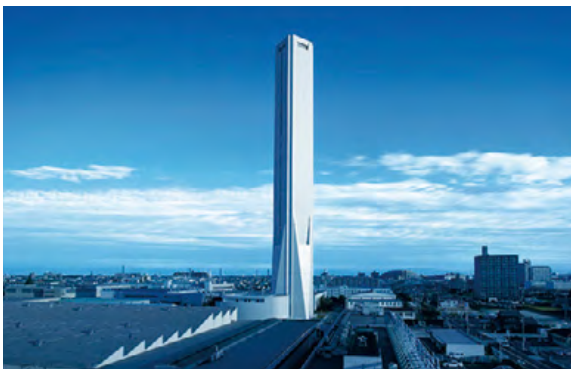
エレベーター試験塔「SOLAÉ(ソラエ)」
