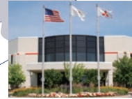
北米FAセンター North America FA Center MITSUBISHI ELECTRIC AUTOMATION, INC.
