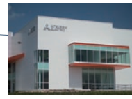
メキシコFAセンター Mexico FA Center Querétaro Office, Mitsubishi Electric Automation, Inc.
