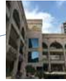
メキシコ・モンテレイFAセンター Mexico Monterrey FA Center Monterrey Office, Mitsubishi Electric Automation, Inc.
