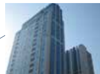
上海FAセンター Shanghai FA Center MITSUBISHI ELECTRIC AUTOMATION (CHINA) LTD.
