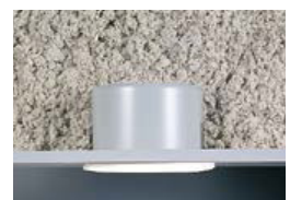
ブローイング工法
