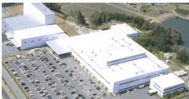
掛川北工場全景
