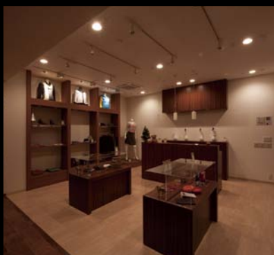
壁面棚上部 (ユニバーサルダウンライト) クラス75 (ハロゲンランプ50W相当) 配光: 左20°/右15° 電球色 (3000K)
