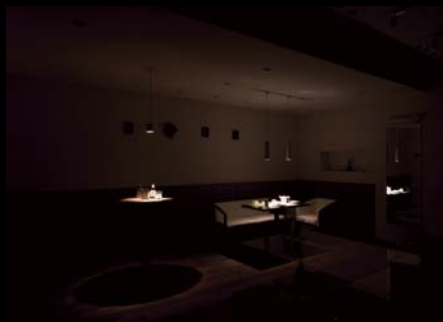
テーブル上部(ペンダント) クラス75(ハロゲンランプ50W相当) 配光:20° 電球色(3000K)
