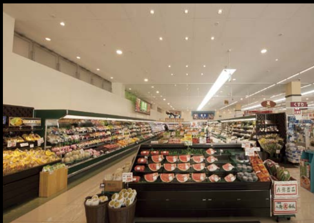
商品に対しては、LEDユニバーサルダウンライトで照射し、商品面照度を高めています。
