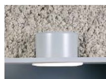
ブローイング工法
