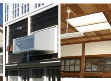
自然採光用光ダクト
