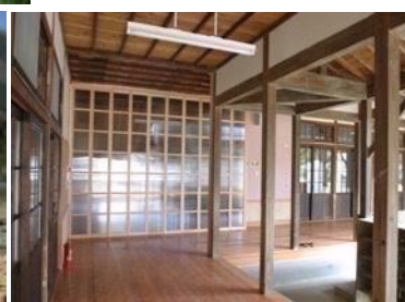
階段室の防寒間仕切り
