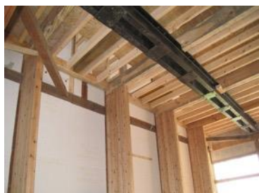
木造校舎耐震改修
