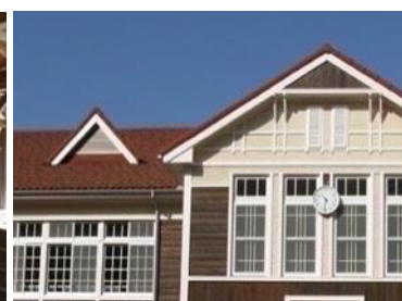
復活した小屋裏換気口
