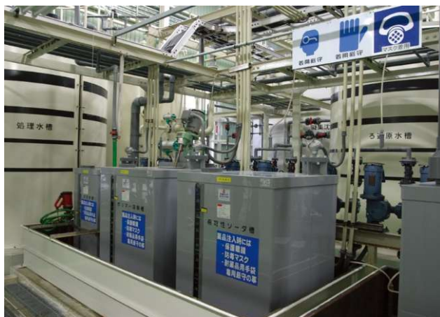
廃水処理施設
