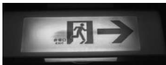
劣化した表示板の例
