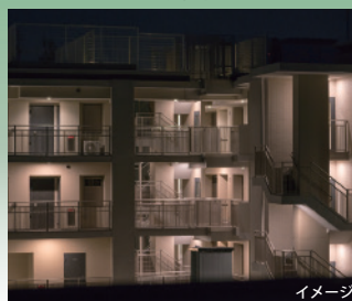
マンションの廊下
