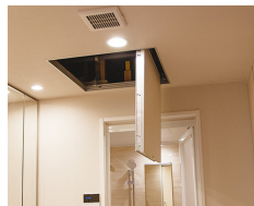
ロスナイをどこに配置するかが今回の設計のポイントだった。最初は洋室で検討され、後にサニタリーに。既存の配管が多いため、天井を100mm下げて設置。点検口は洗面室の天井に設けた
