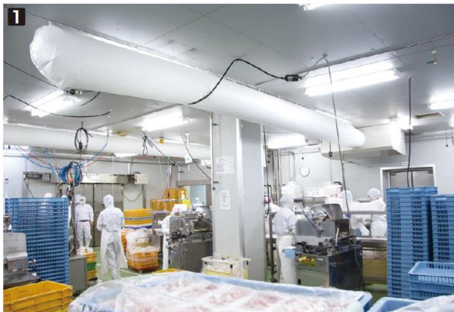
① スライス作業室に設置されたソックダクト対応ユニットクーラUCH-N8CNA。 ダクトの長さは約7m
