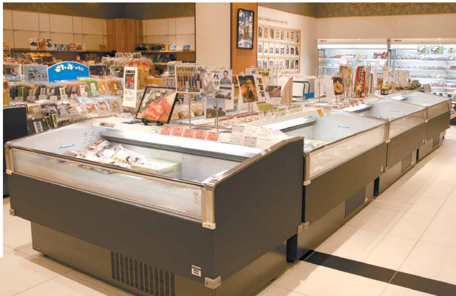
▲店内中央に設けた冷凍食品のアイランド。6尺の内蔵平形ケース(SG-JS680BTVE)7台で構成されている。集中設置による排熱処理に課題は残すが、支障があればレイアウト変更できる点は内蔵ケースの強み
