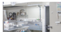
▲厨房にも業務用エコキュートで給湯
