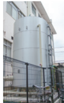
▲中庭に設置された貯湯槽
