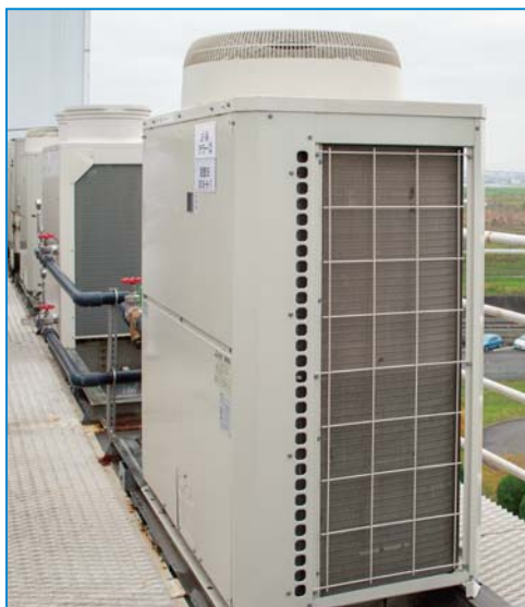
▲年間を通し、安定して冷水を供給可能な産業用インバータチリングユニット
