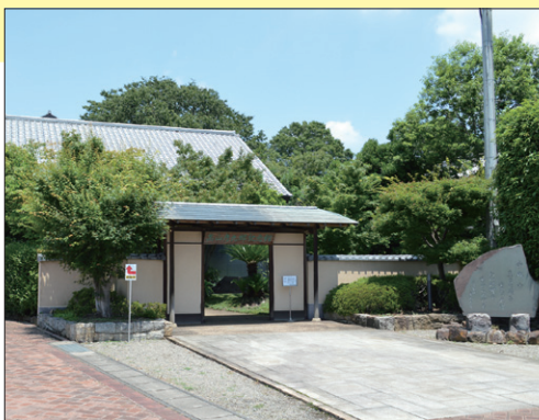
納入機種 設備用パッケージエアコン ファシレアDD PFHV-P80DMJ1×2台
