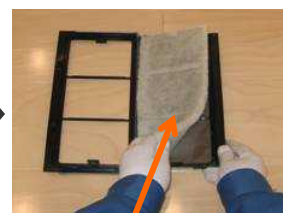
外気除じんフィルター
