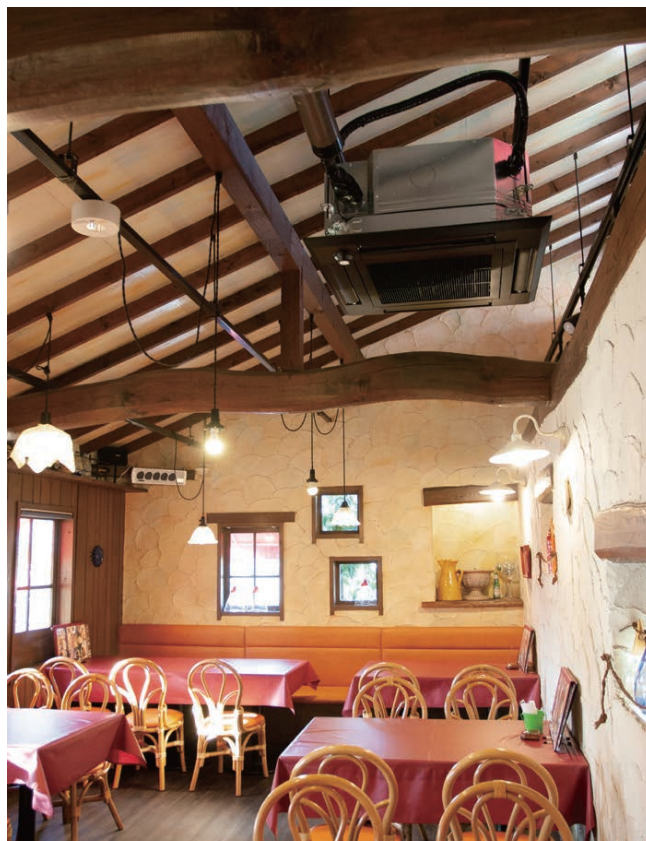
▲西側の客室。室内ユニット（P224形ツイン）はブラックパネルを選定。配管周りも黒のダクトテープで丁寧にカバー。
