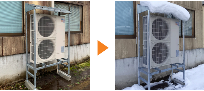
▲防雪屋根の装着と架台設置で積雪に対策
