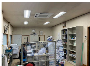
▲室内ユニットが設置された事務所
