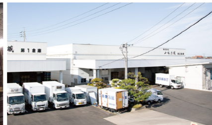
▲右が今回設備更新した第2倉庫で1991年竣工。左は1988年会社設立時からの第1倉庫
