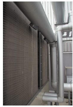
▲地下ピット内の冷気を熱源機吸込み側に取込むことによる夏季省エネへの期待は大きい
