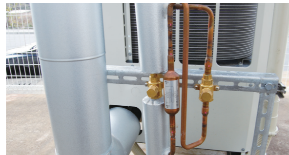
▲活性炭の吸着メカニズムで、配管内に残留する塩素化合物・スライム・残油劣化物を除去できるリプレースフィルタ
