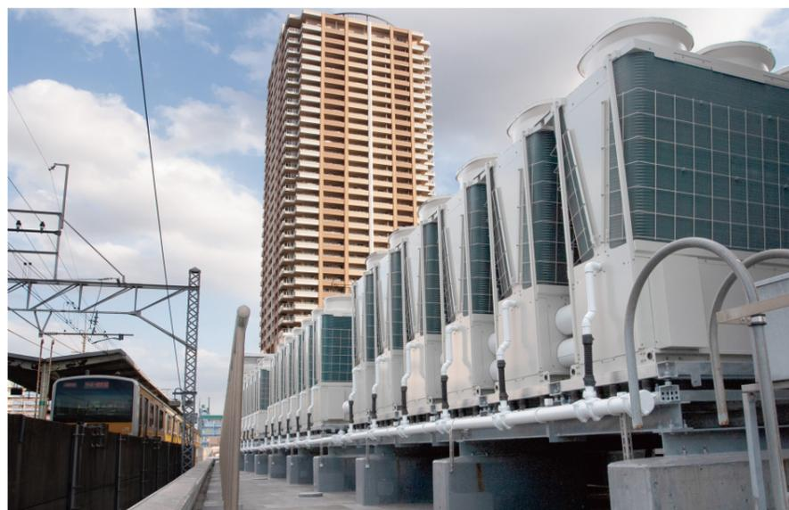
▲空冷式ヒートポンプチラーDT-RⅡ(60馬力×18台)は屋上に設置。すぐ脇を総武線が走る
