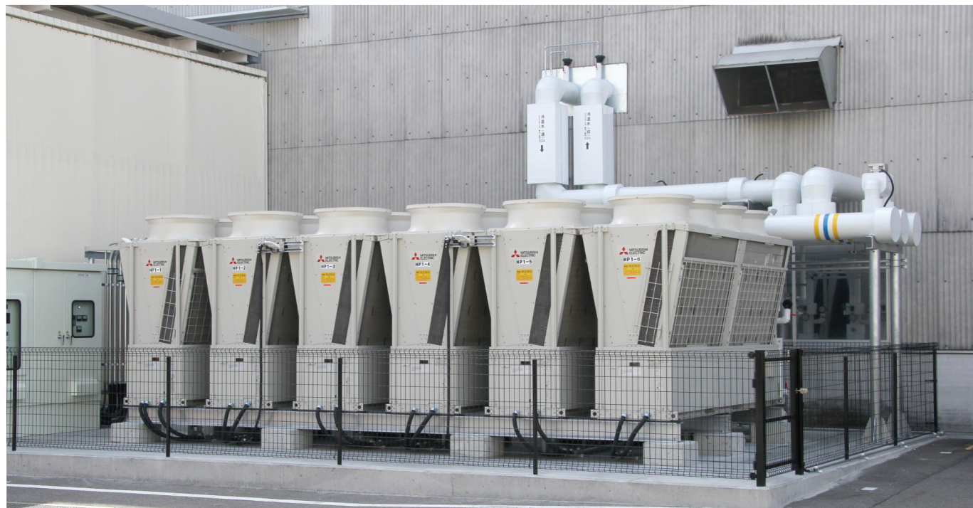
▲アルミ扁平管熱交換器の採用により、空冷式ヒートポンプチラーDT-RⅢは冷房運転時の吸込温度を上限52℃まで拡大、暑い夏でも冷房運転が継続できる
