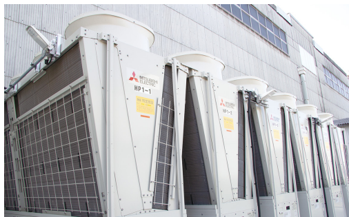
▲安全確保の観点から、両端のユニットにはフィン保護網を装着
