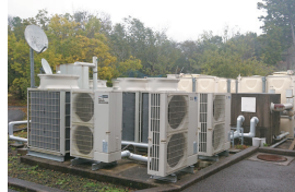
▲個別空調用のパッケージエアコン(リプレースグランマルチ、Fitマルチ、スリムZR)
