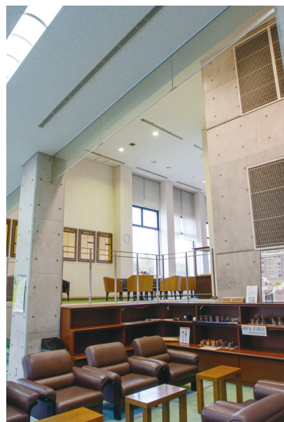
▲ロビーやレストランはセントラル空調。丸型・スリット型の給排気口が見える
