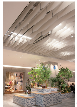
▲新館1階のレストスペース。上部にファンコイルユニットの吹出口が見える。セントラル空調はAIで制御、人流を含めて各種データを蓄積中
