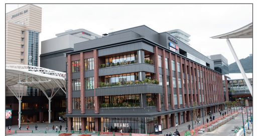
▲新長崎駅ビルは、CASBEE建築評価認証の4スター (Aランク) を取得。左が本館とJR九州ホテル長崎、手前新館の高層階が長崎マリオットホテル
