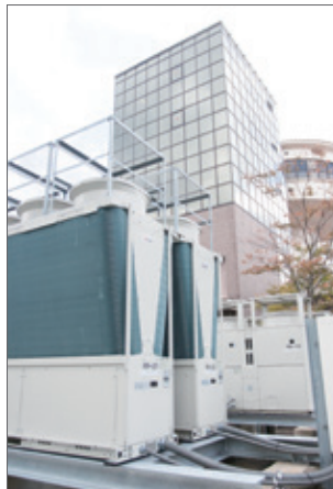
▲フローリングの「ふれあいホール」(写真)の暖房にはヒートポンプチラー(空調機はAHU)を使用。砂敷きの「多目的ホール」は、換気のみ
