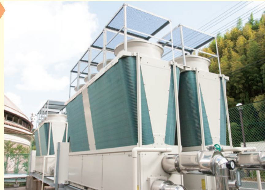
▲給湯用熱源にはホットウォーターヒートポンプCAHV・P500AK2-H-BSG)が5台採用された。貯湯温度は以前50℃だったが、熱源更新後は67.5℃。以前より高い湯温で供給でき、給湯や温泉昇温に使いやすくなった
