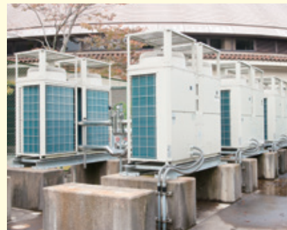
▲給湯用熱源にはホットウォーターヒートポンプCAHV・P500AK2-H-BSG)が5台採用された。貯湯温度は以前50℃だったが、熱源更新後は67.5℃。以前より高い湯温で供給でき、給湯や温泉昇温に使いやすくなった
