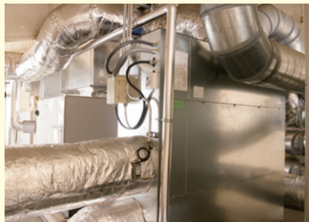
▲床置ビルトイン形ロスナイ(LB-200K-80形)。CO₂センサーでダクト内CO₂濃度を検出し、外気導入量をコントロール
