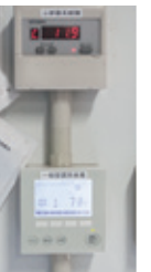
▶貯卵室系統(DT-R)は出口水温7℃、孵卵機系統(コンパクトキューブ)は11.9℃に設定
