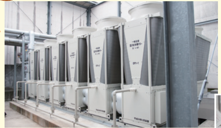
▶貯卵室系統(DT-R)は出口水温7℃、孵卵機系統(コンパクトキューブ)は11.9℃に設定
