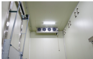
▲冷蔵庫に設置されたR463A仕様のユニットクーラ
