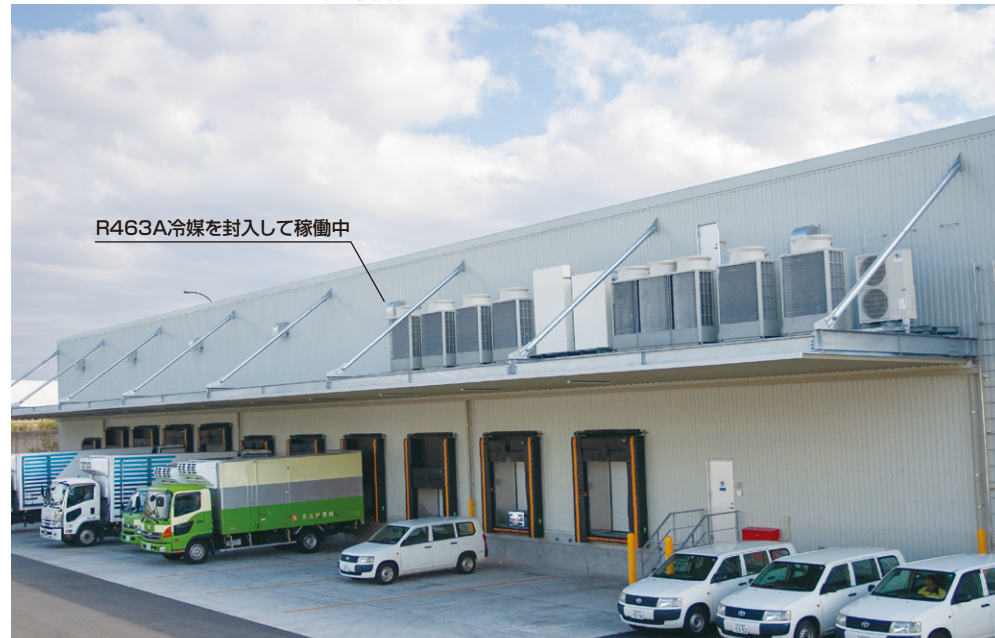
▲冷蔵庫に設置されたR463A仕様のユニットクーラ
