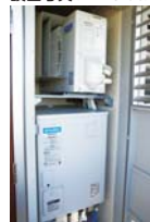
エコキュート 設置写真(ドア閉鎖時)
