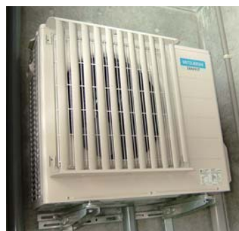
②ヒートポンプユニット設置写真
