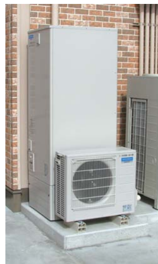
エコキュート 設置写真
