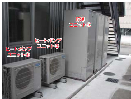
貯湯ユニット、ヒートポンプユニット設置写真
