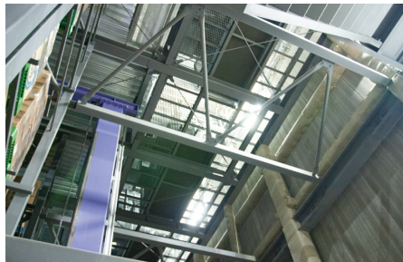
▲建築手法は「ラックビル式冷凍倉庫」。空洞部をみるとラックが構造材の荷重を支えていることがよくわかる。グレーチングの上がユニットクーラ
