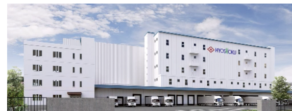
▲右側が既築の冷凍倉庫。中央奥が新設した自動ラック倉庫
