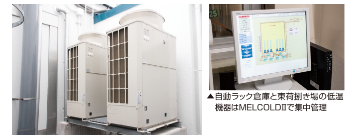
▲自動ラック倉庫と東荷捌き場の低温機器はMELCOLDIIで集中管理
