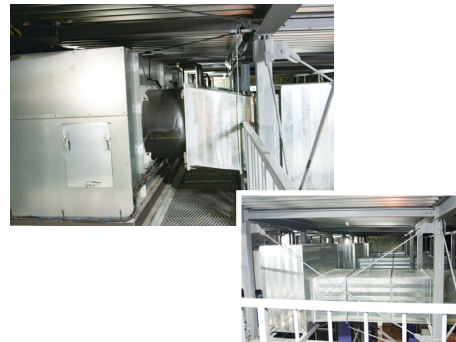
▲建築手法は「ラックビル式冷凍倉庫」。空洞部をみるとラックが構造材の荷重を支えていることがよくわかる。グレーチングの上がユニットクーラ
