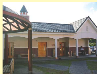
▲トイレの外観からも景観への配慮が窺える。
