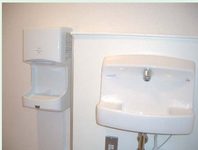
▲▶ ジェットタオルミニ。独自のノズルでスピード乾燥と低騒音化を達成
