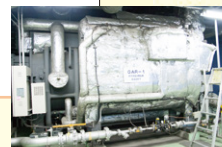
①ガス焚き吸収冷温水機は630Rtと400Rtの2台
