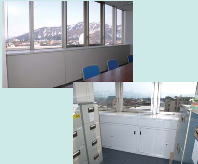
事務室窓面の1スパン(6.4m)に4台ずつ2面に均等に設置されています。 (■風量の考え方...1スパンあたり600m 3 /hに設定)
