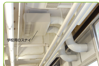
学校用ロスナイの給気・排気のダクト配管の様子です。
