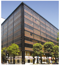
▲SRC造、地上9階・地下6階・塔屋3階。B1は面積約4,000㎡、階高4.0m、共用部天井高2.6m。一体建築となっている帝劇ビルと連絡
