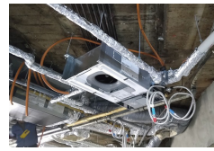
▲天井裏の吊りこみ具合
