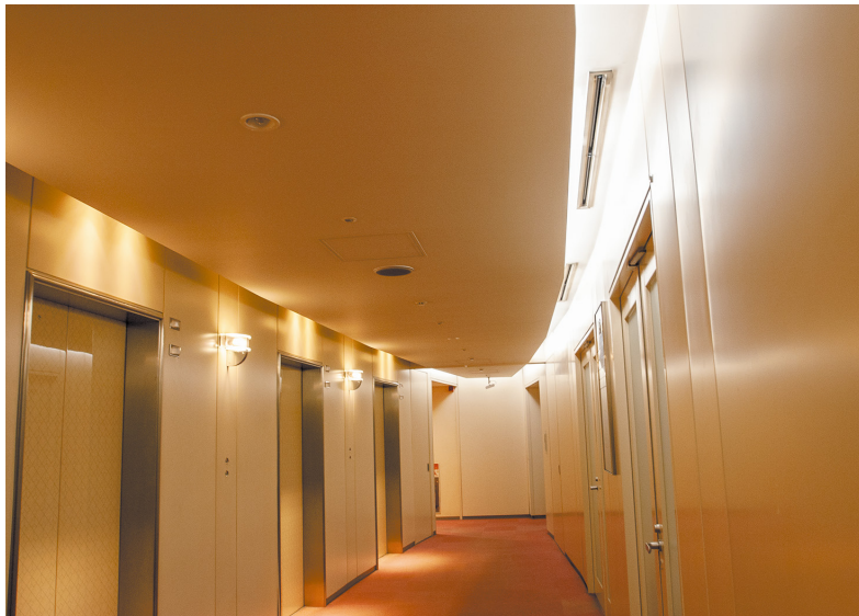
▲コアに位置するエレベーターホール。空調吹出口はラインスリット型
