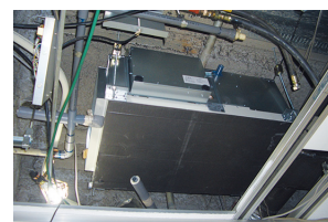
▲天井裏に設置された水冷式のMBHV形ユニット。コンパクトなインバータ仕様
