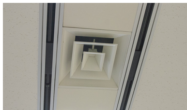
▲室内側はアネモの左右に見えるスリットが空調吹出口
