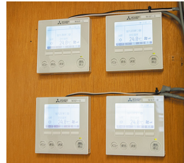
▲水冷式パッケージエアコンのリモコンは制御盤内に収納
