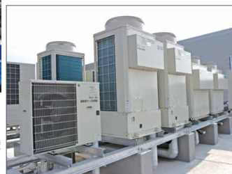
▶熱源機は1階屋上と建屋外壁沿いに集中設置。海が近いため、耐塩害仕様が主
