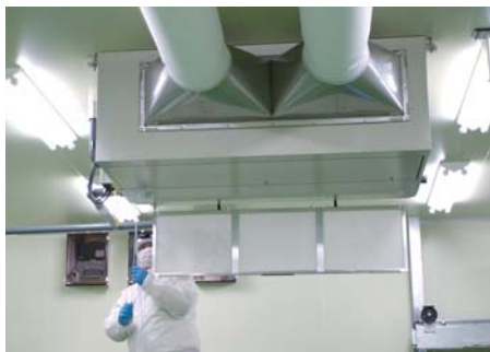
▲室内ユニットには、メンテナンスの手間を軽減する手動昇降フィルターを採用
