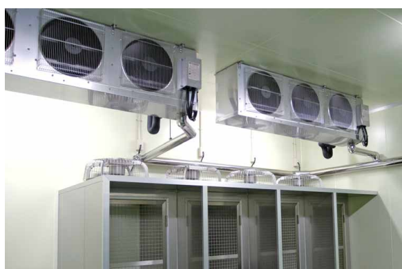
▲トッピング室や包装室はソックダクト式の中低温用パッケージエアコンで室温を13℃に維持
