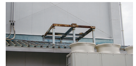
▲既設クーリングタワーを撤去してスッキリした屋根上。メンテナンスの容易さは、水冷式から空冷式に切り替えた要因の一つ
