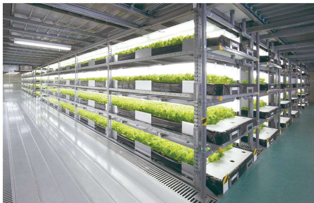
▲ほぼ無菌状態に近い室内で水耕(養液)栽培されるレタス。施設照明には、三菱電機のFHF 32W蛍光灯器具トラフ形5,504台を採用。育苗用のみLEDにすることで初期コストを抑制した
