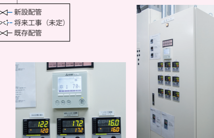
▲チラーのリモコンは機械室の制御盤に設置された
