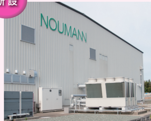
▶ 負荷側のエアハンドリングユニット(AHU)
