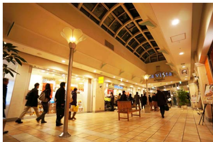
南棟2F共用通路 LEDダウンライトにリニューアル 昼間はトップライトにて昼光も入ります。
