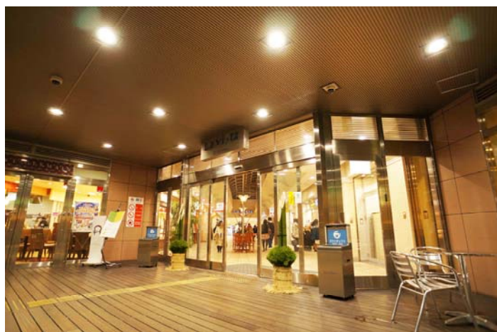
南棟2F入口 軒下用LEDダウンライトにリニューアル 白色4000Kで落ち着いた雰囲気となっています。
