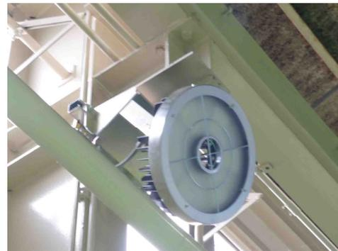
壁際の照明器具は、壁面取付金具にて設置
