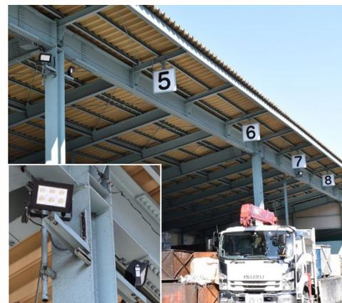
金属材料の販売・回収及び機械加工などの複合企業である花村産業では、アルミ原料を元にアルミ二次合金を製造するアルミニウム工場の高天井照明を水銀ランプからLEDにリニューアルしました。アルミニウム工場は、高温、粉塵、腐食性ガスの発生する過酷な環境でこれまでLED照明の利用が困難な状況にありました。しかしながら2020年末に水銀ランプの製造が中止される状況にあり、消費電力の大幅削減も図れることから、この度LED照明への交換を決定しました。三菱電機照明では、様々な環境における高天井器具の開発を進め業界トップクラスの豊富なバリエーションを誇っています。今回その技術力をベースに過酷なアルミ鋳造工場の環境下でも使用可能な器具を開発、導入に至りました。消費電力は段調光も利用することで大幅に削減出来たことはもちろんのこと、工場内は飛躍的に明るさが増し作業効率もアップしました。また、製造ライン以外に倉庫、搬出ヤードの投光器のLED導入も同時に行い、大変ご好評を頂いています。
