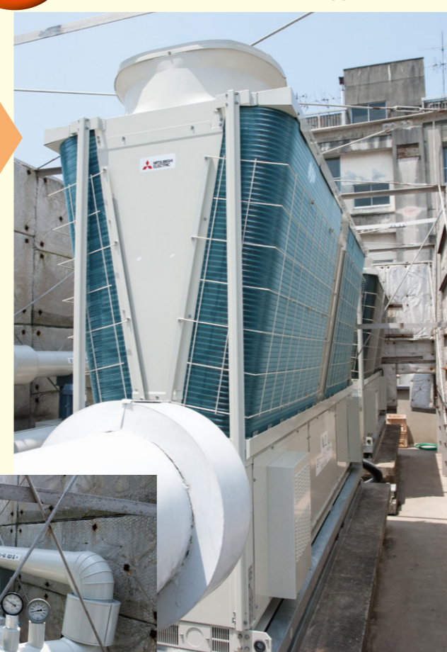
▲配管のとりまわしとポンプ。防音板は既設を利用
