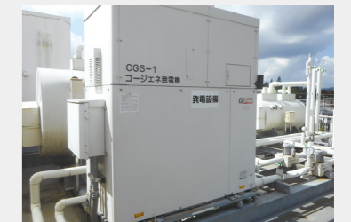
▲GHPとの複合利用で動力系統のデマンド抑制に使っていたガスコージェネレーションシステム
