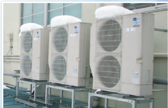
▲1階屋根上に室外ユニットを設置
